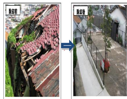
図 2 空き家の除去後に小さい公園として活用されている例
