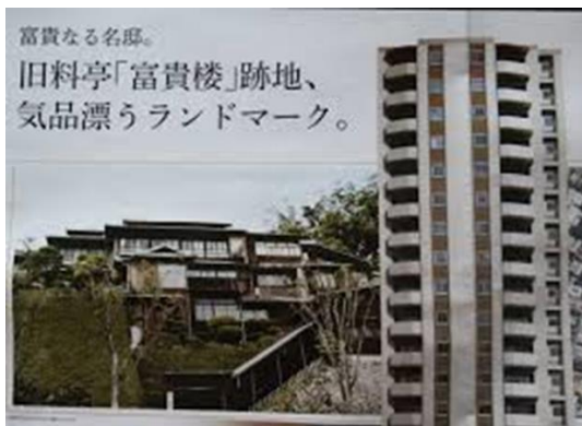
写真1 取り壊し前後の事例
